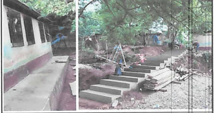
FOTO 2: FUNDICIÓN EN BANQUETA DE CONCRETO Y GRADAS
